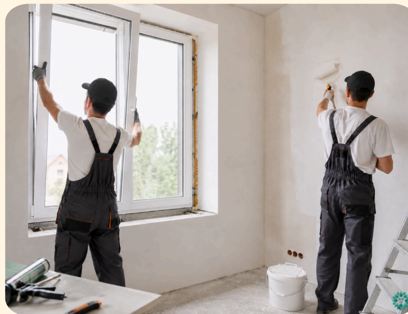
Lucrări de vopsitorie, zugrăveli și montări de geamuri
