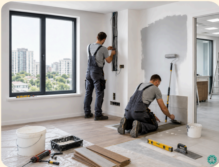
Lucrări de instalații electrice, de pardosire și placare a pereților
